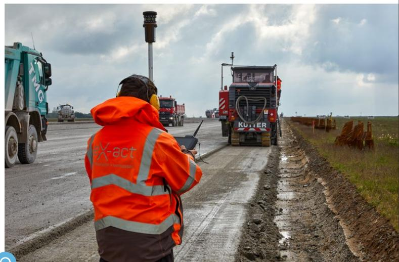
Mit Kontrollmessungen unmittelbar hinter den Großfräsen wurde die Höhenlage der Frässpur kontinuierlich überprüft.
