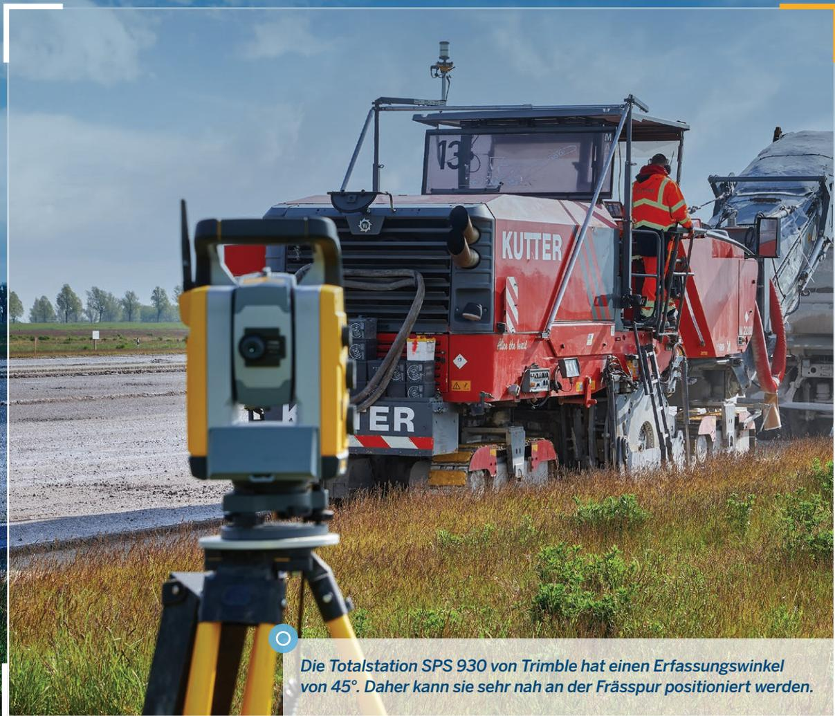
Die Totalstation SPS 930 von Trimble hat einen Erfassungswinkel von 45°. Daher kann sie sehr nah an der Frässpur positioniert werden.
